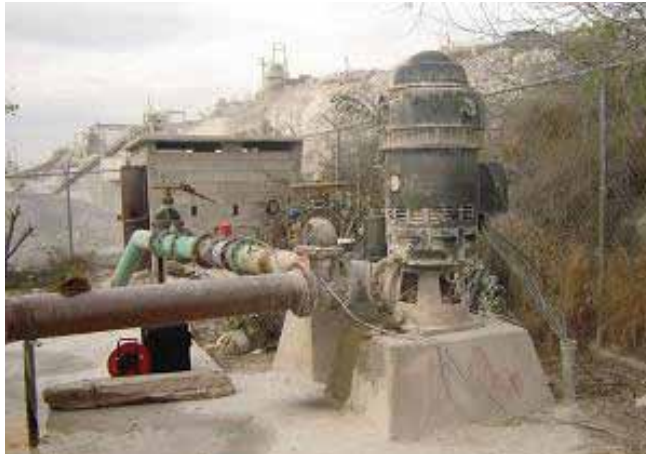
Figura 5.1 Equipo de bombeo con eficiencia baja
