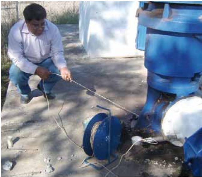
Figura 1.21 Medición del nivel dinámico de succión en cárcamos de rebombeo
