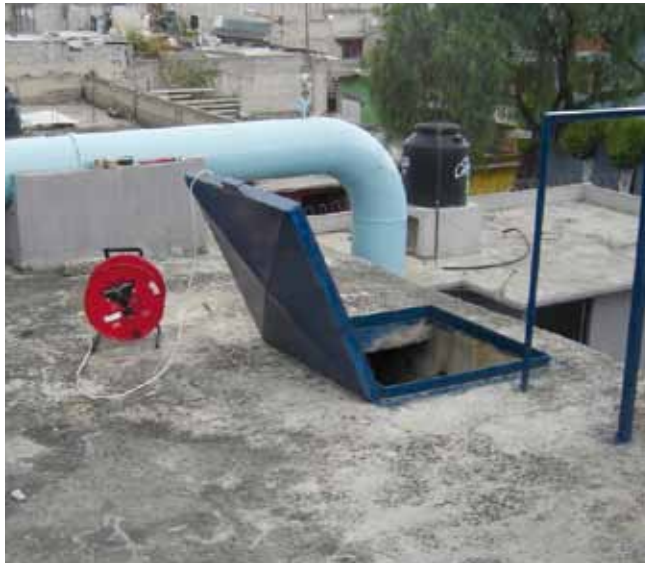
Figura 1.22 Medición del nivel dinámico en cárcamos de bombeo
