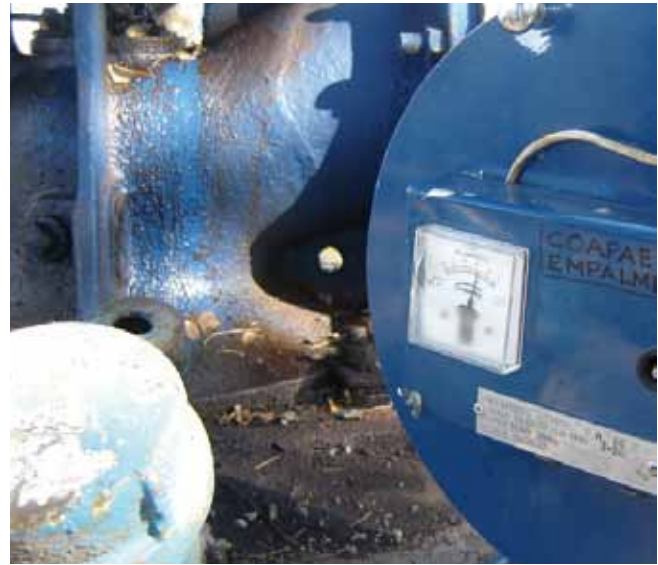
Figura 1.21 Medición del nivel dinámico de succión en cárcamos de rebombeo
