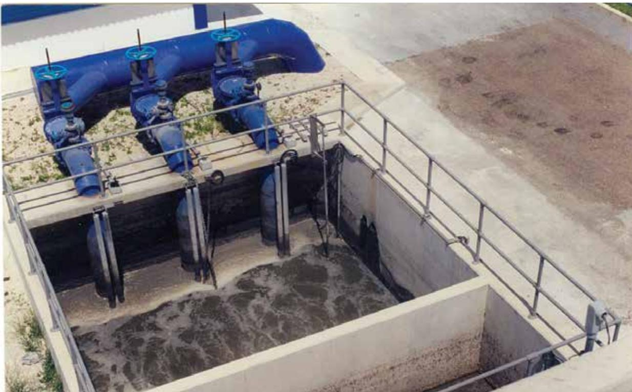
Ilustración 1.3 Obra de llegada y desvío (demasías o bypass) antes del desarenador en una planta de tratamiento de aguas residuales
