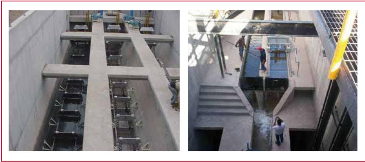
de colección de arena. La Ilustración 1.22 muestra un desarenador aireado.
