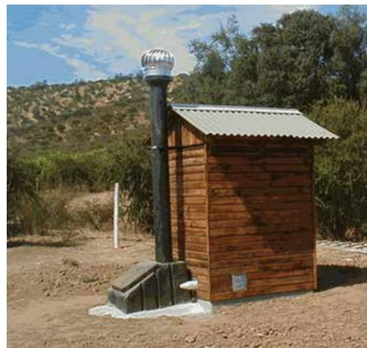
cámara menor, donde se acumulan y culmina el proceso de descomposición, que dura aproximadamente un año. Después de este tiempo se extrae la composta, que es de buena calidad y fácil obtención. Para facilitar su extracción, la cámara menor se puede dejar fuera de la casa.
