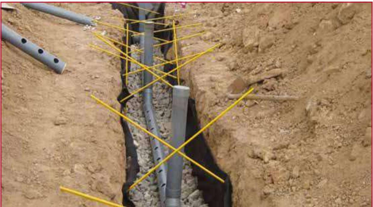
por material con granulometría entre 2.0 y 5.0 centímetros. Sobre ella se ubica la tubería de distribución y se le cubre totalmente con la misma grava. Encima de la grava gruesa se coloca una capa de grava fina de 0.10 m de espesor y granulometría de 0.5 a 2.0 centímetros. La Ilustración 3.3 muestra una vista de la zanja totalmente cubierta.
