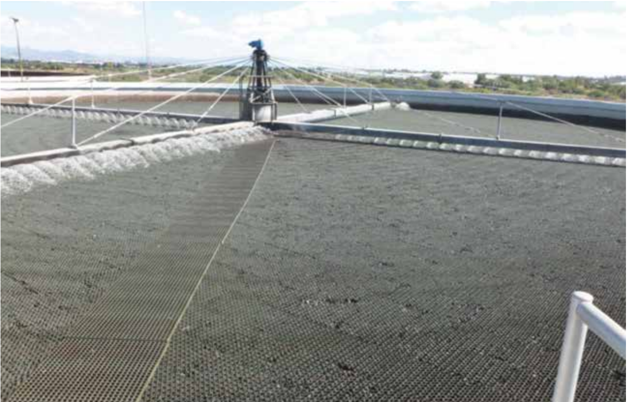
Ilustración 2.7 Medio de soporte de bloques de plástico
