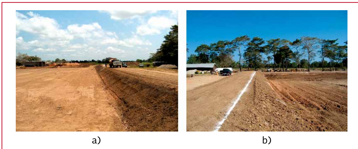
Ilustración 2.16 Construcción de taludes mediante arcilla
