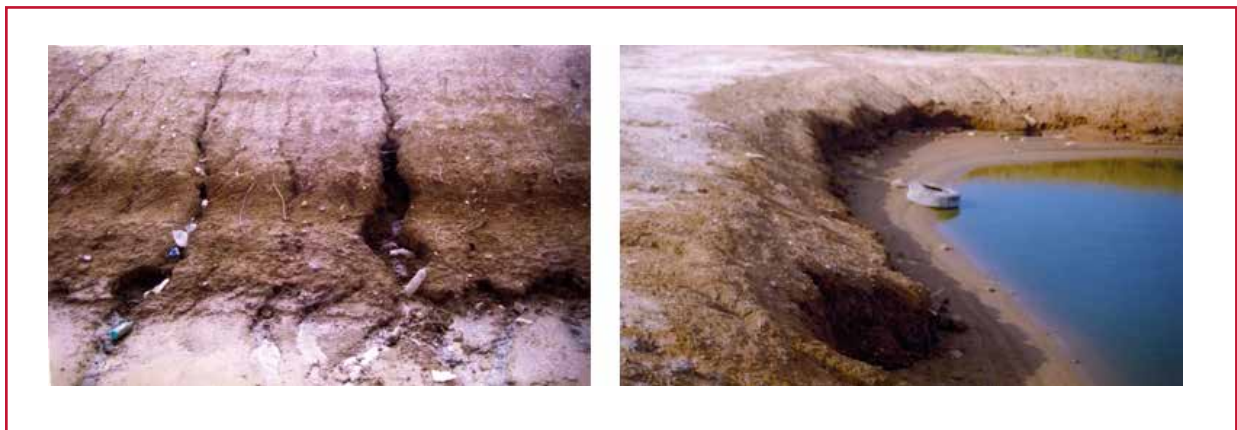
Ilustración 2.10 Bordos construidos con materiales inadecuados
