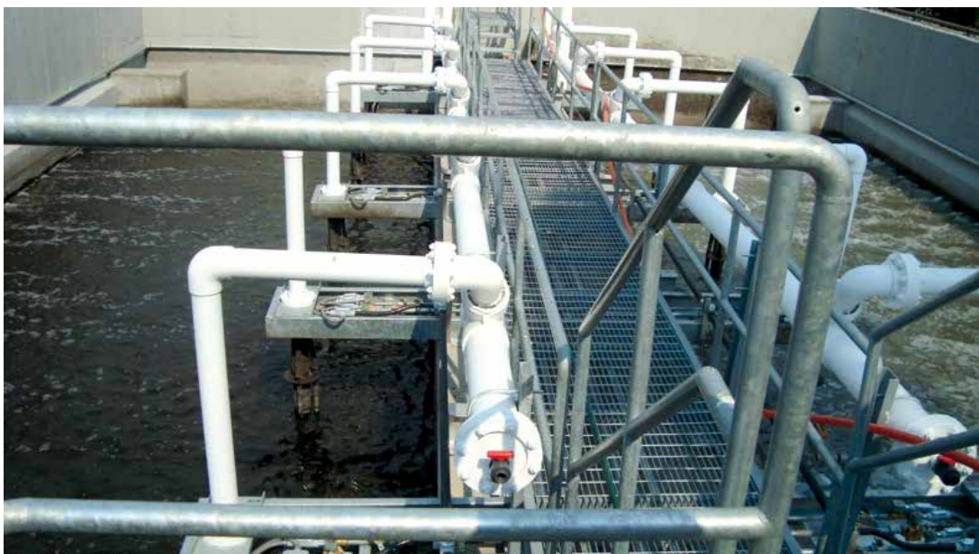
Ilustración 1.8 Desarenador aireado
