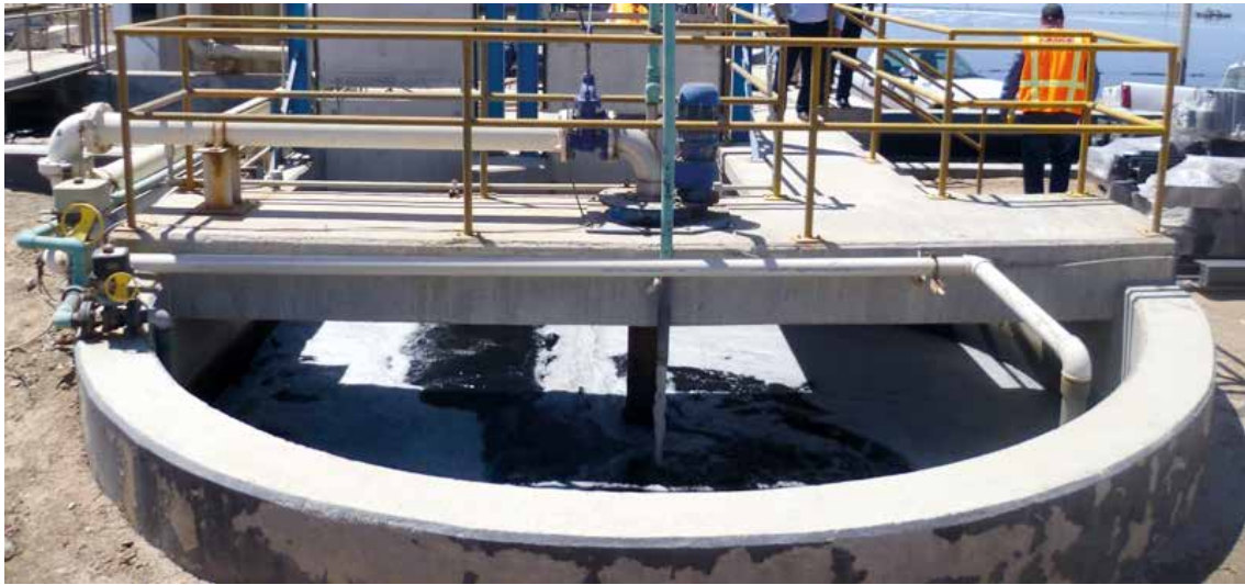
Ilustración 1.12 Desarenadores de vórtice a) Sistema PISTA b) Sistema Teacup
