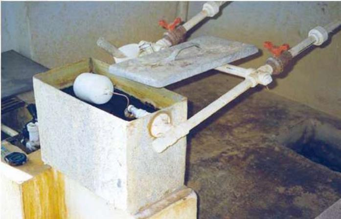
Dosificador de tubo con orificio, en flotador
