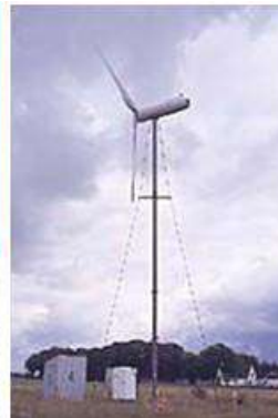
Torre de mástil tensado
