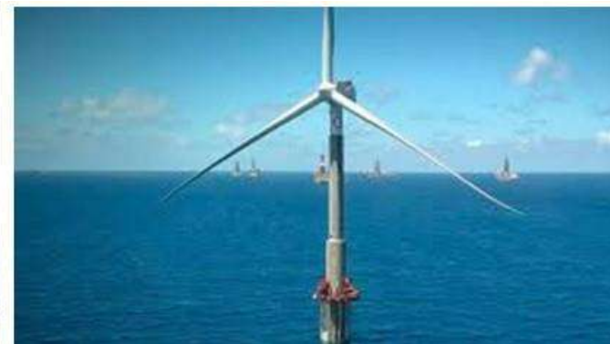
Torre de hormigón
