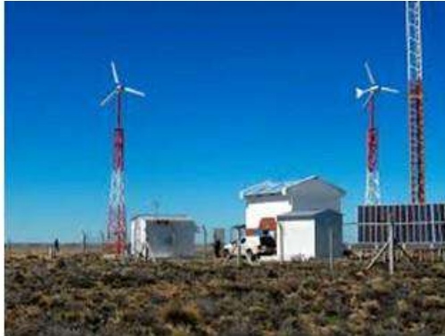
Torre de celosía
