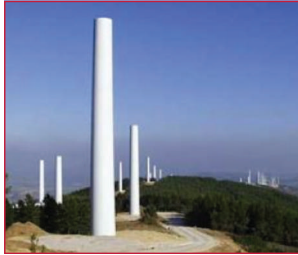
Ilustración 2.30 Aerogenerador tipo torre tubular
