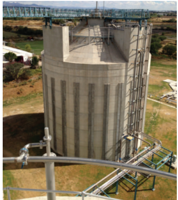
Ilustración 3.17 Lanzas para el mezclado del biogás y torre biológica para eliminación de H_2S
