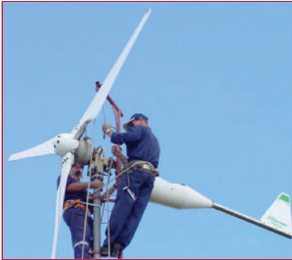
Ilustración 2.40 Instalación de aerogenerador.
