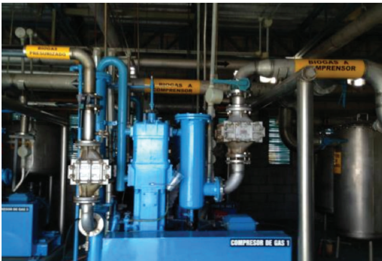
Ilustración 3.19 Sistema de compresión de biogás
