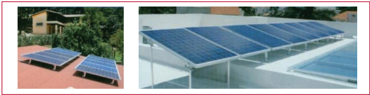
Ilustración 4.37 Instalación en techo
