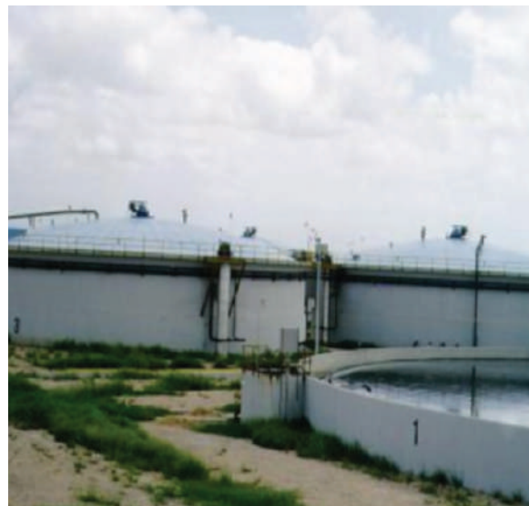
Ilustración 3.9 Reactores anaerobios de la planta de tratamiento
