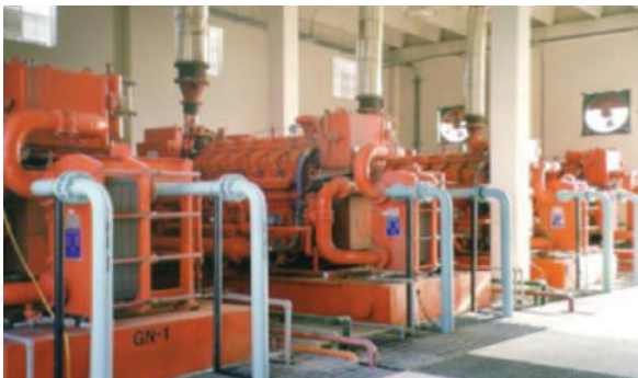
Ilustración 3.12 Unidades de cogeneración
