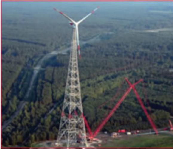
Ilustración 2.29 Aerogenerador tipo torre de celosía
